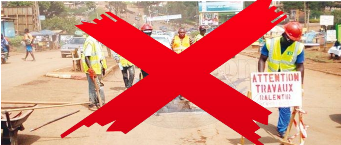
Réalisation de travaux de tranchée au milieu de la voie publique
